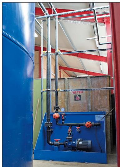
*Befüll- und Dosierstationen (bei Bedarf mit Durchflußmessung), Verrohrung der gesamten Chemikalienstationen.*
